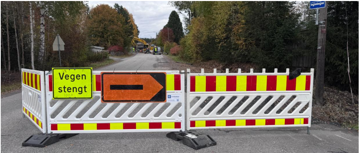
Figur 11: Stengt vei i forbindelse med anleggsarbeider. Bilde fra kommunens arkiv.
