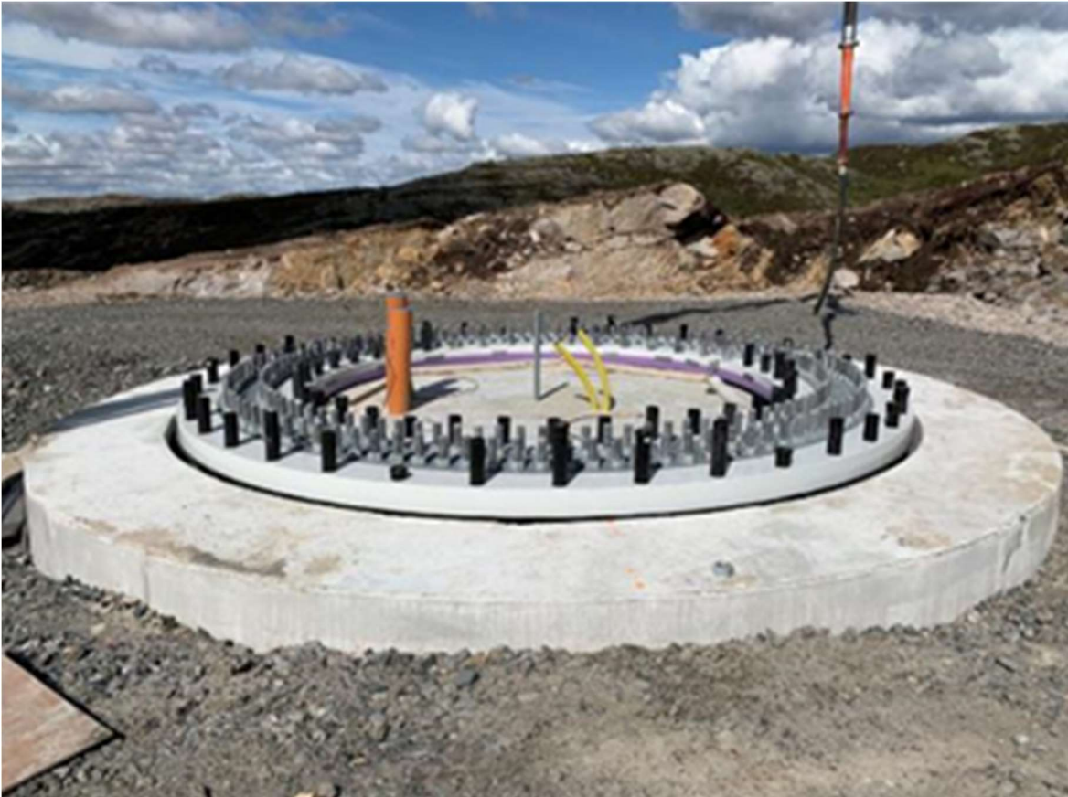
Figur 4-2: Turbinfundament i Tonstad vindkraftverk. Foto: Tonstad Vindpark AS
